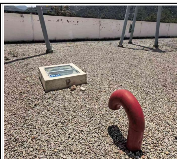
新建事故油池
