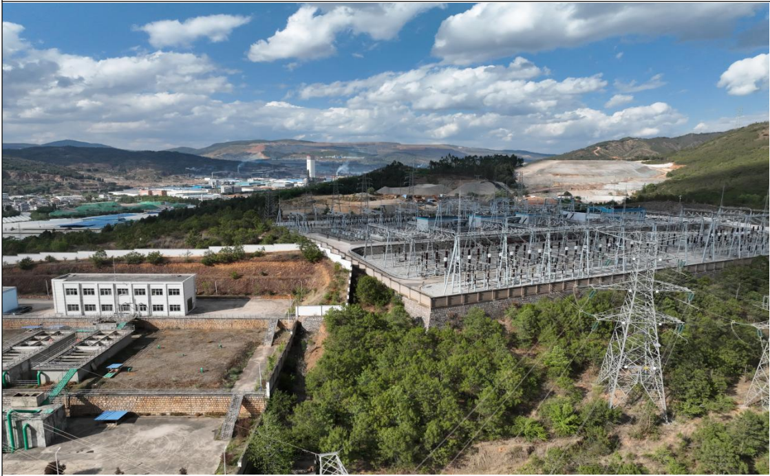
220kV 樟木箐变电站鸟瞰图
