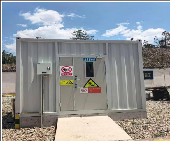
新建危废贮存库
