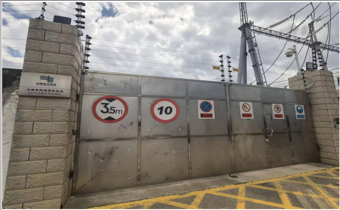
220kV 樟木箐变电站正门
