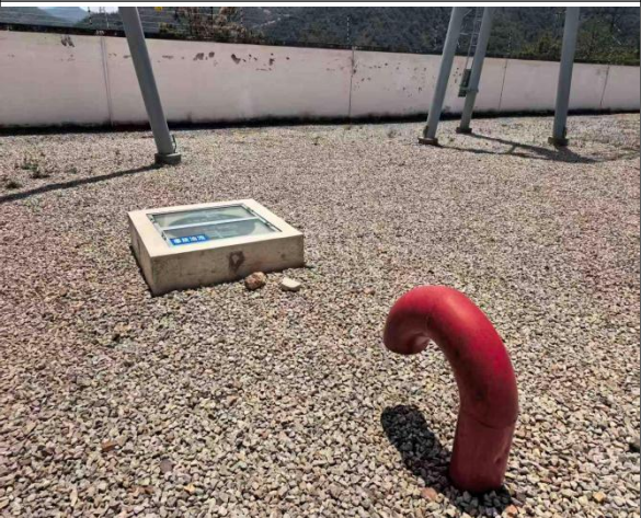
新建事故油池
