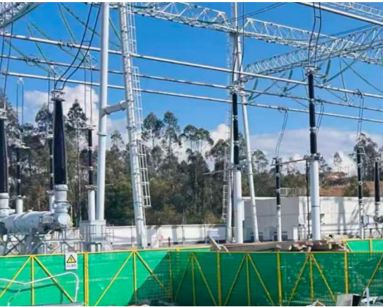
施工作业区域进行围挡
