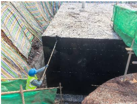
事故油池外层刷沥青
