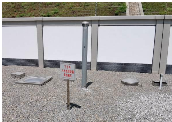
地埋式污水处理装置
