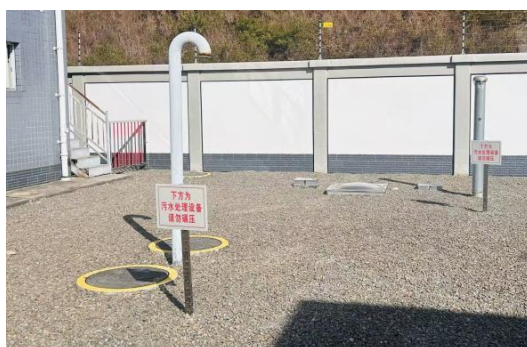
图9-2 生活污水处理设施照片
