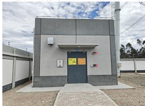
本期新建危废暂存间
