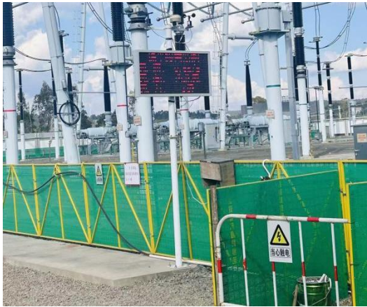
施工作业区域进行围挡
