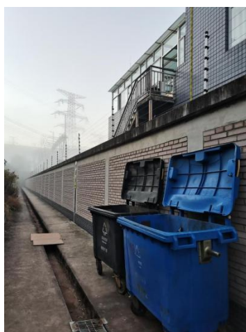
图10-1 500千伏鹿城变电站垃圾桶
