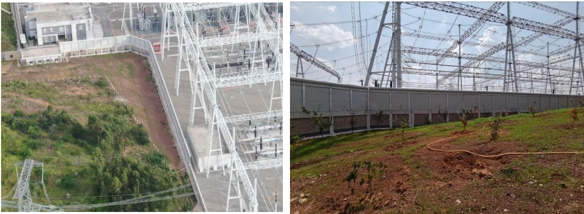
二期工程已建隔声屏障
