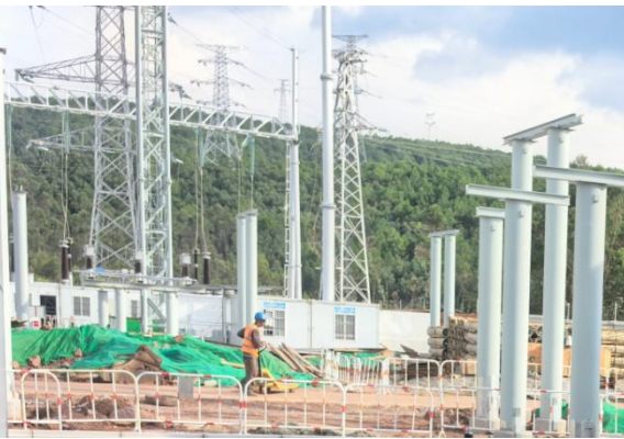
施工作业区域进行围挡、临时堆土遮盖
